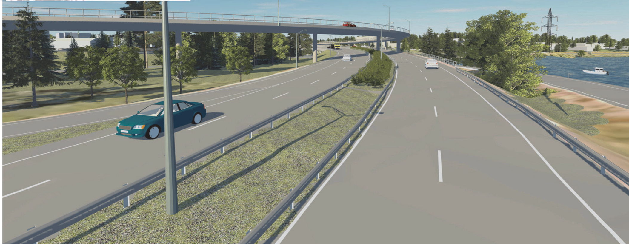
Kuva 3. Aholaidan eritasoliittymä Vt 9 Tampereen suunnasta pohjoiseen.
