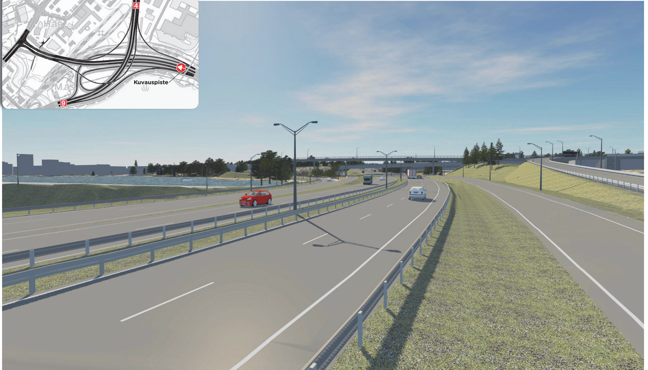
Kuva 4. Aholaidan eritasoliittymä Vt 4 / Vt 9 idästä länteen.
