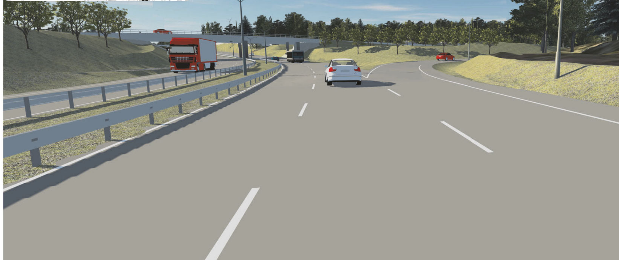
Kuva 9. Seppälän eritasoliittymä Vt 4 etelästä pohjoiseen.
