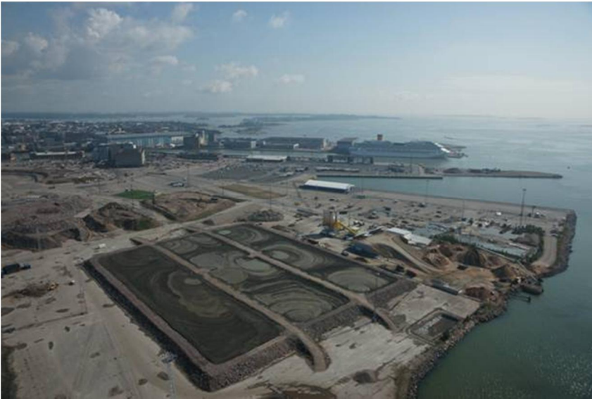
Figure 12.6 Jätkäsaari I – stabilisation basins
