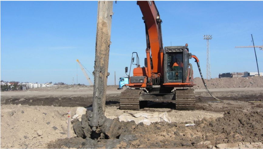
Picture 12.23 Jätkäsaari III : stabilisation work in progress
