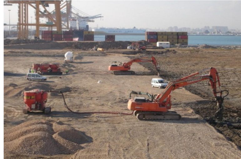
a) Massastabilointialtaat Vuosaaren satamassa (lähde: Vuosaaren satama), b) massastabilointi käynnissä Valencian satamassa (lähde: ALLU).
