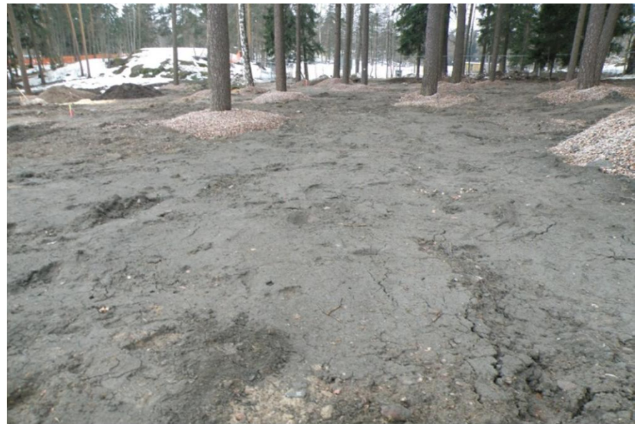
Ida Aalbergin puisto. Syvästabiloitujen ylijäämäsavien hyödyntämistä Ida-Aalbergin puistossa (lähde: Aino-Kaisa Nuotio)
