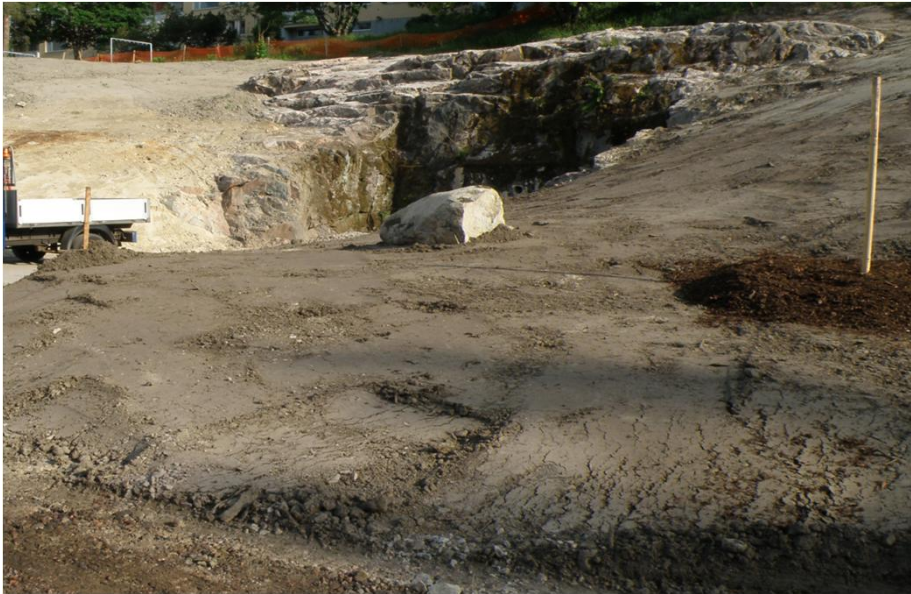
Ida Aalbergin puisto. Syvästabiloitujen ylijäämäsavien hyödyntämistä Ida-Aalbergin puistossa (lähde: Aino-Kaisa Nuotio)
