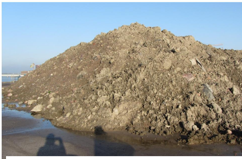
Stabiloitua sedimenttiä varastokasalla
