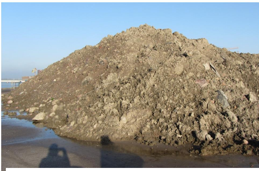
Stabiloitua sedimenttiä varastokasalla
