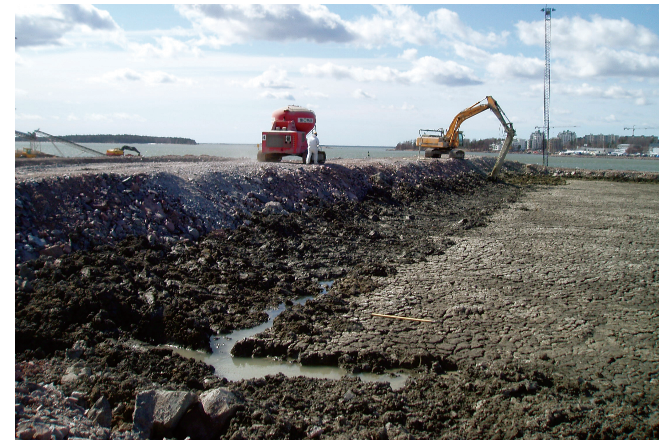
Ongoing Mass Stabilisation.
