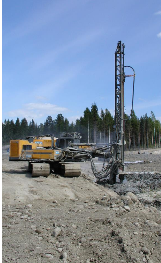
Column stabilisation (in-situ)
