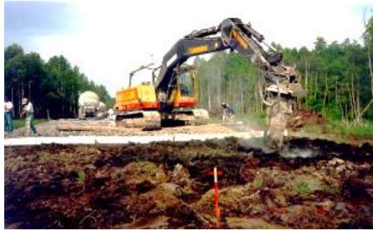
Mass stabilisation ongoing
