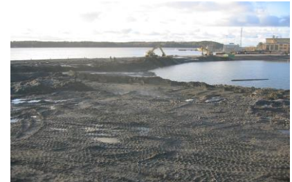
Utilisation in harbour fillings
