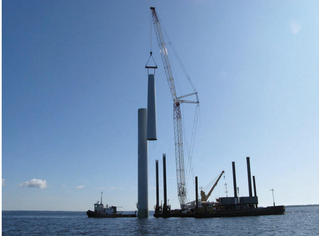
■ Kuva 6-12. Voimalaitostornin pystytystyö käynnissä Ajoksen koeperustushankkeessa kesällä 2009.
