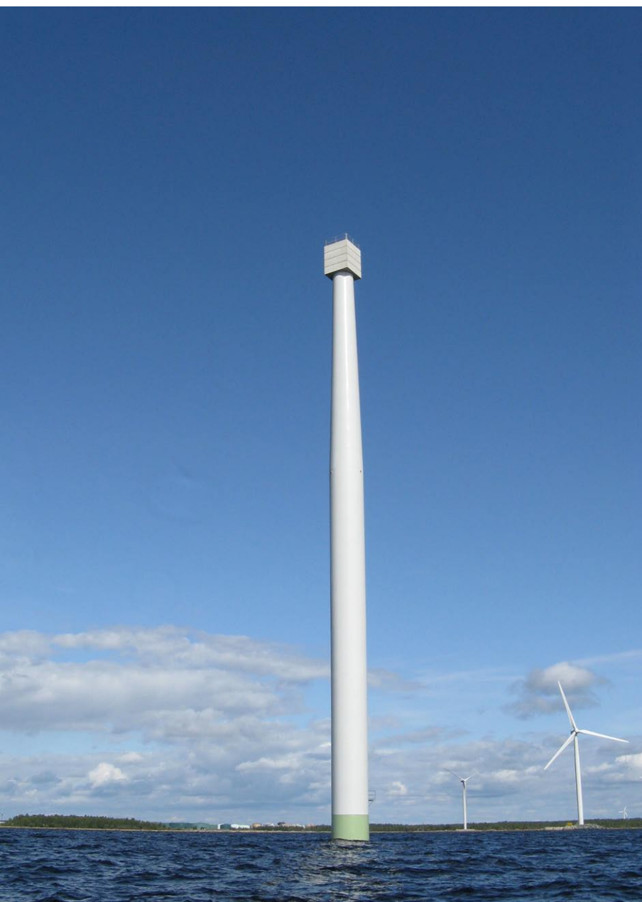
■ Figur 6-12. Resning av kraftverkstornet vid bygget av ett försöksfundament i Ajos sommaren 2009.
