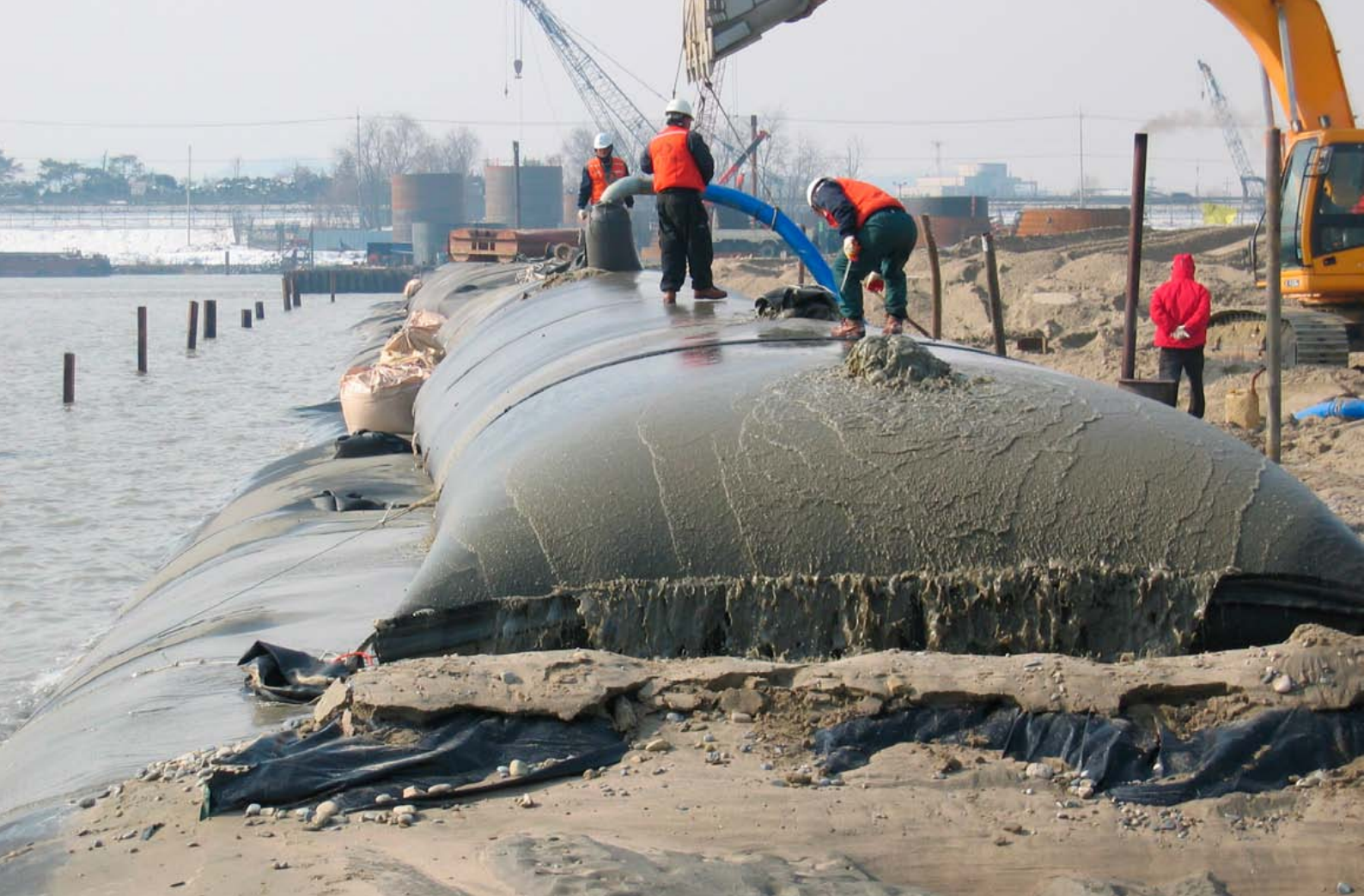
Kuva 4-8. Sedimentin kuivatus geosäissä (lähde: http://supertechinc.com/products/geosynthetics/geotextiles.shtml ).
