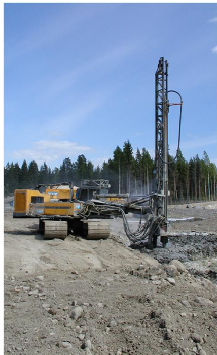
Column stabilisation (in-situ)
