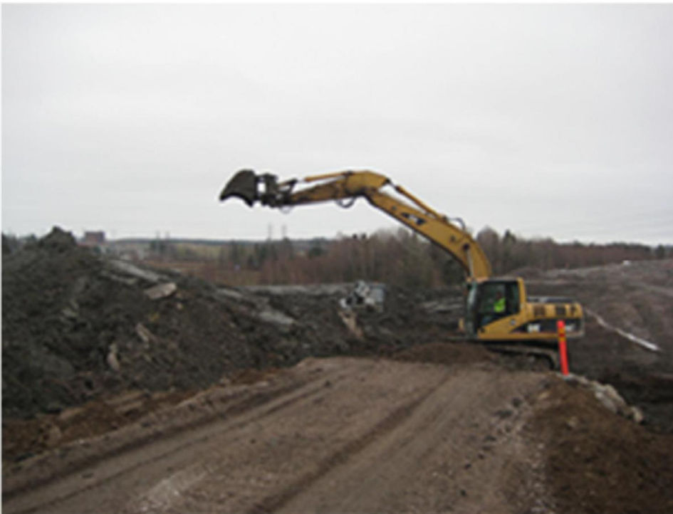
Picture 3. Jätkäsaari II sediments applied in Vuosaari landfill structures.
