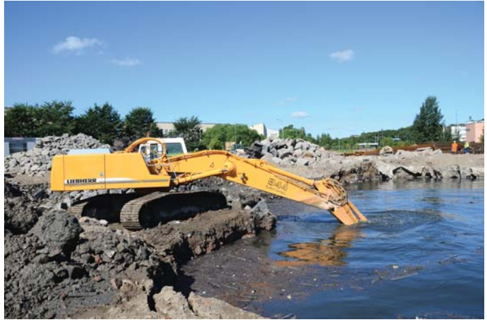
Kaivannosta poistetaan louhetta.
