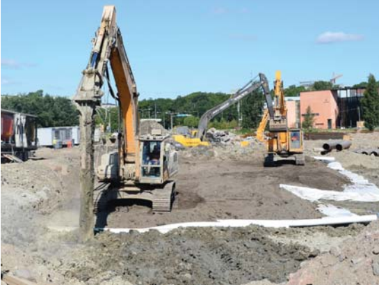
Käynnissä oleva stabilointityö.
