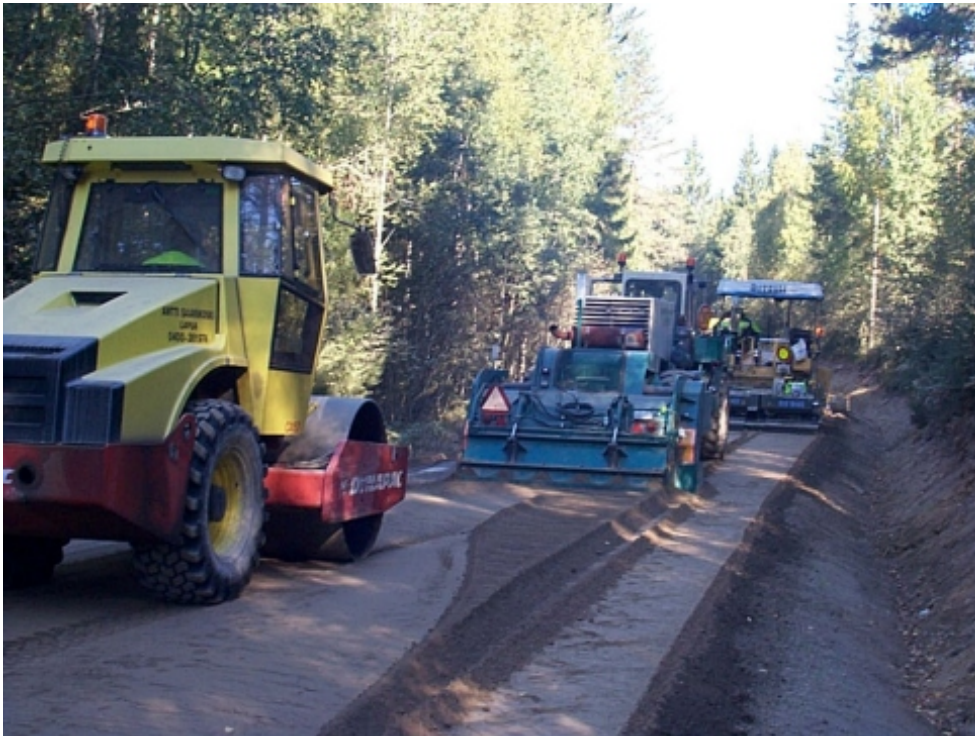
Kuva 11: Kerrosstabilointi tuhka-sideaine -seoksella. Pilot 2002, Kukkia Circlet
