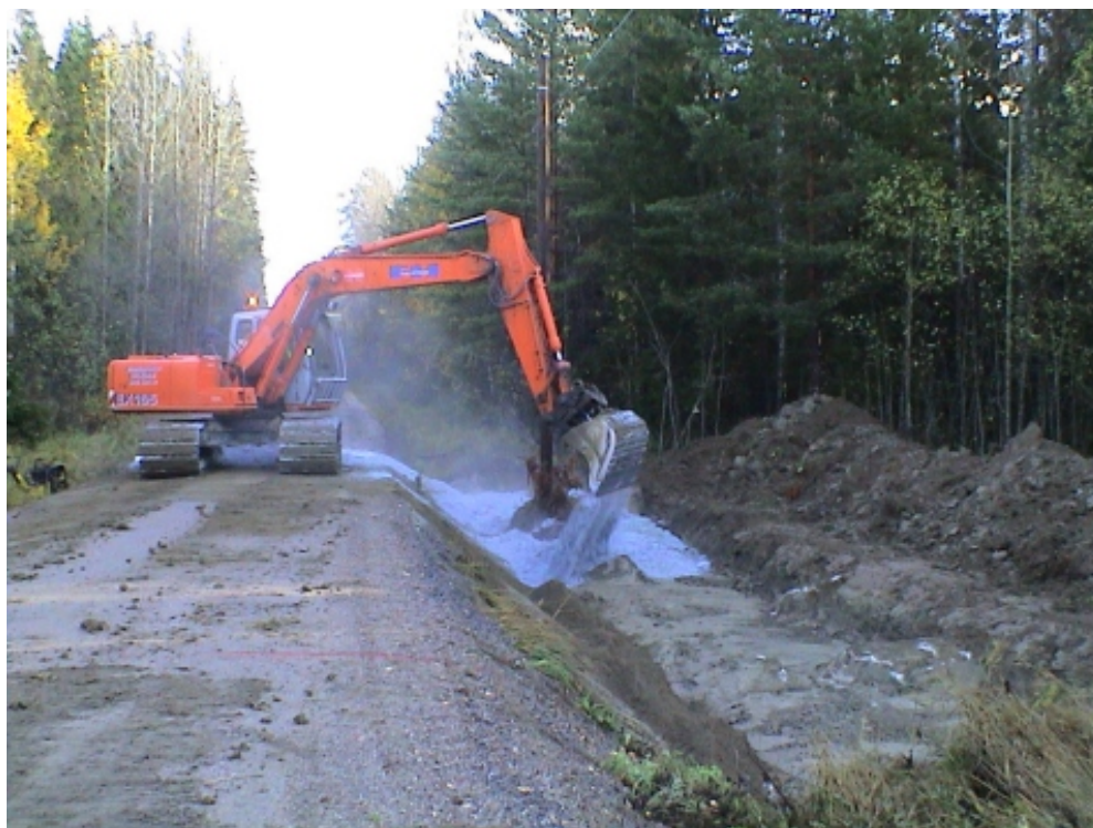
Kuva 15: Kuitusaven levitystä ojaan pohjaveden suojausrakennetta varten. Pilot 2003, Kukkia Circlet
