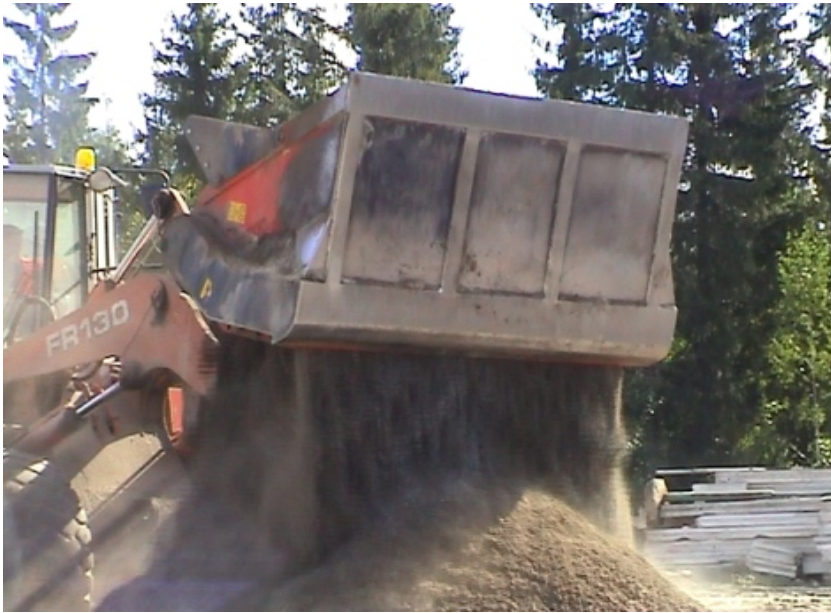
Kuva 9A: Materiaalien sekoitusta kauhasekoittimella. Kukkia Circlet
