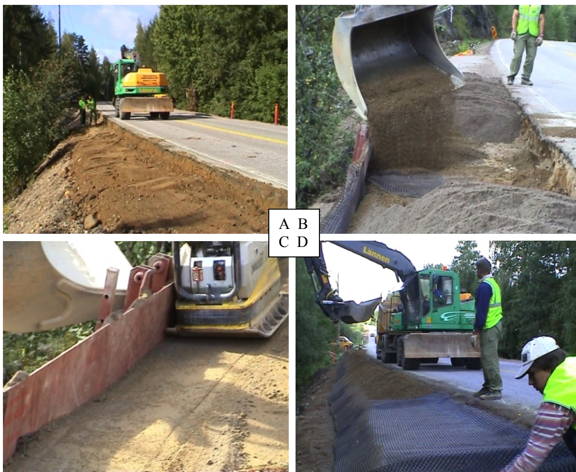
Kuva 14: Piennarlevennyksen tekoa. A. Kaivettu ja tasattu luiska. B. Tukilevyn käyttö kuitutuhkan levityksessä. C. Kuitutuhkan tiivistys murskeen päältä. D. Kuitutuhkarakenteen tekoa ilman tukilevyä. Pilot 2003, Kukkia Circlet
