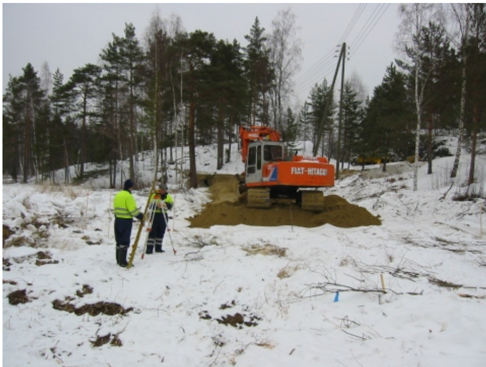
Kuva 13: Moreenipenkereen tekoa pehmeikölle kevyen liikenteen väylää varten. Pilot 2003, Kukkia Circlet
