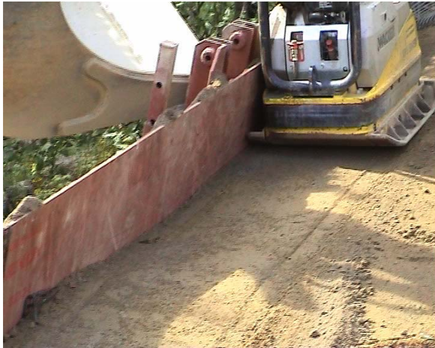
Kuva 13: Muotin avulla pussitetun kuitutuhkakerroksen päälle on ajettu murske ja rakenne tiivistetään. Luopioinen Kt 322, 2003.
