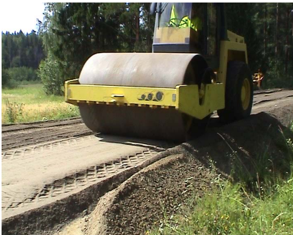
Kuva 19: Kuitutuhkakerroksen päälle levitettiin noin 5 cm mursketta, ja kerrokset tiivistettiin jyrällä täryttämällä. Pihtisalmentie, Luopioinen, 2003
