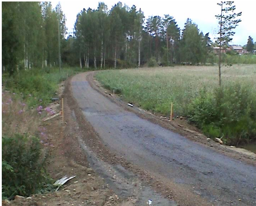
Kuva 8: Kevyen liikenteen väylä rakenteilla; pohjalle tiivistetty mursketta ja tehty reuna-paltteet, ja ensimmäinen erä kuitutuhkaa on levitetty murskeen päälle. Luopioinen kesällä 2003.
