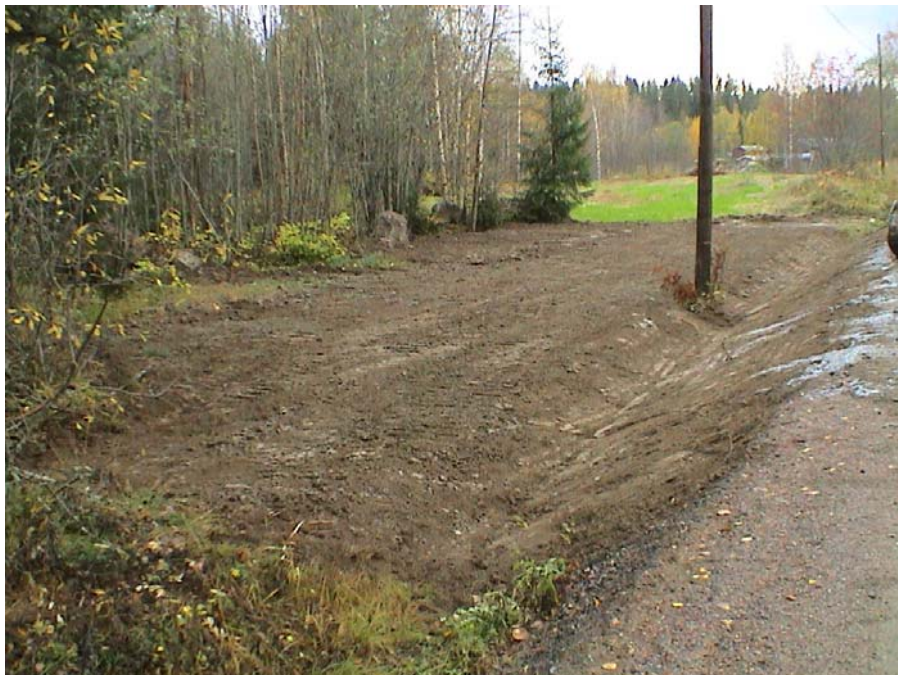
Kuva 24: Valmis pohjavedensuojaurakenne. Pihtisalmentie, Luopioinen, 2003.
