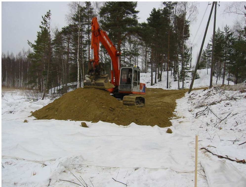
Kuva 6: Pohjanvahvistusta (geovahvisteen levitys ja penkereen teko) pehmeiköllä maaliskuussa 2003. Luopioinen
