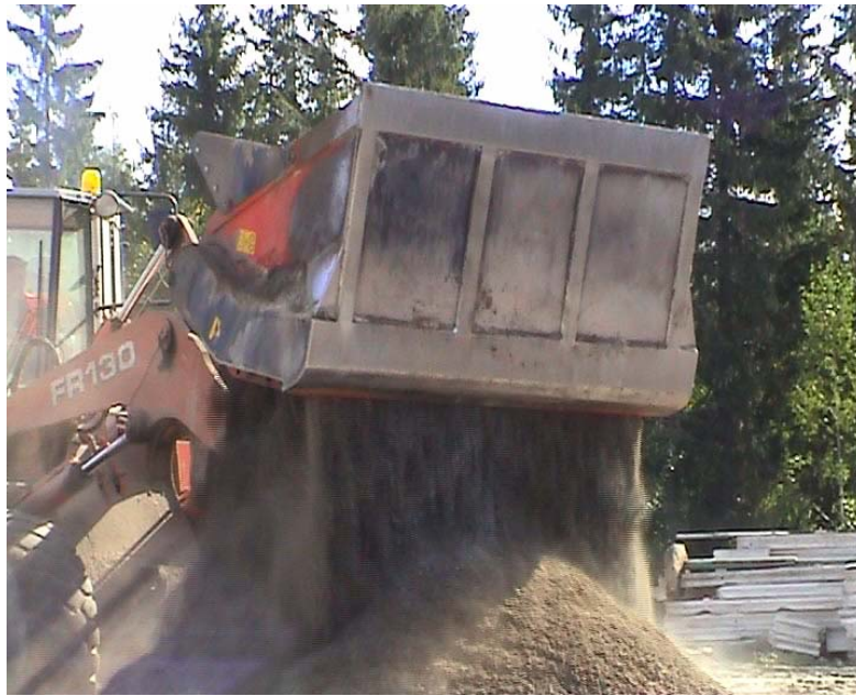
Kuva 5: Sekoitusta kauhasekoittimella Rankkimäessä kesällä 2003.
