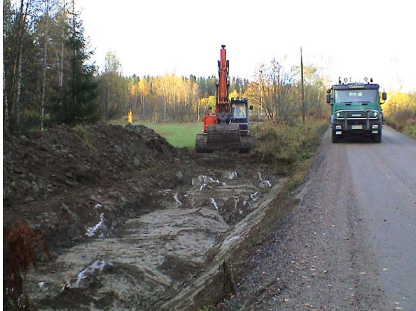
Kuva 21: Pintamaan poistoa rakennuskohteessa. Pihtisalmentie, Luopioinen, 2003.
