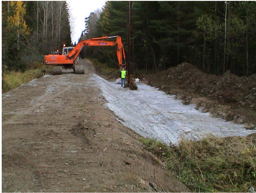
Kuva 23: Kuitusavikerrosta tiivistetään. Pihtisalmentie, Luopioinen, 2003.
