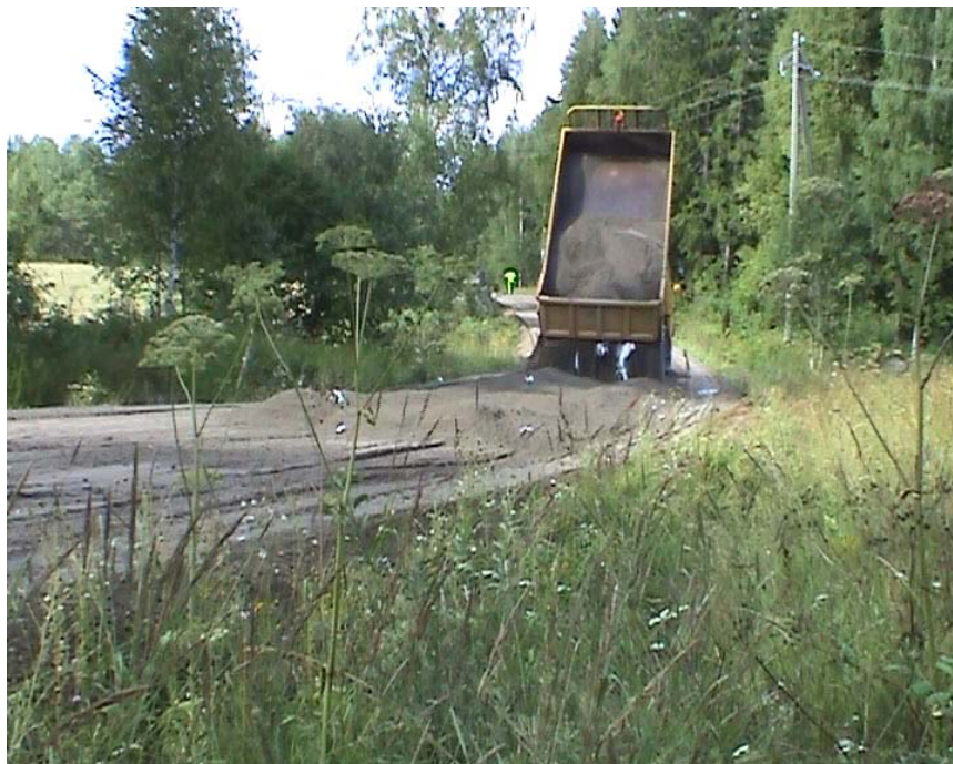
Kuva 17: Soratien pintaan muokattuun ”kaukaloon” levitettiin kuitutuhka kippaamalla auton lavalta. Pihtisalmentie, Luopioinen, 2003.
