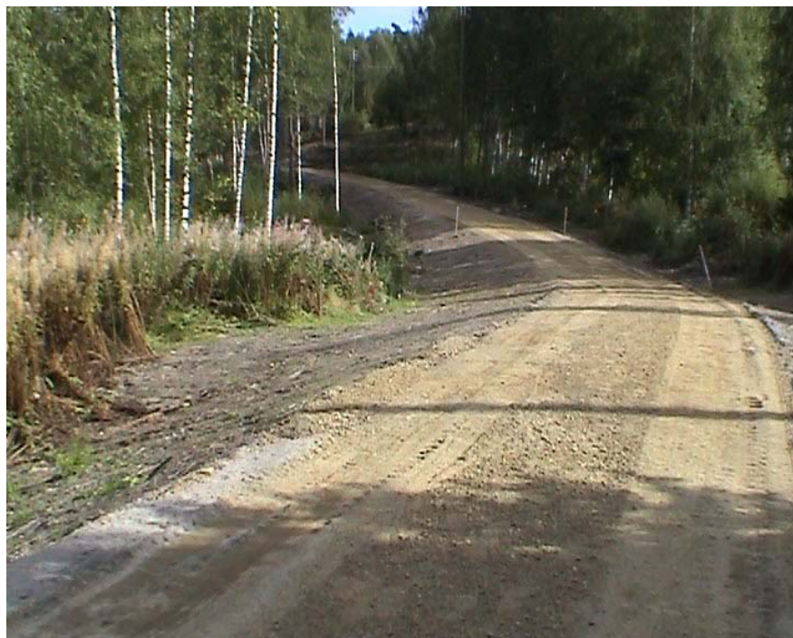
Kuva 9: Viimeisteltyä väylää. Kulutuspinta levitetty ja luiskat muotoiltu. Kulutuspinnan jyräys vielä kesken. Luopioinen kesällä 2003.
