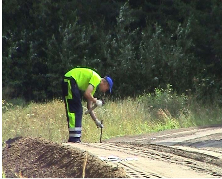
Kuva 26: Kerrospaksuuden tarkistaminen. Luopioinen, 2003.
