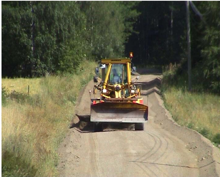
Kuva 16 Soratien pinnasta höylättiin muutama senttimetri pintamurskeita valliksi tienreunaan . Pihtisalmentie, Luopioinen, 2003.
