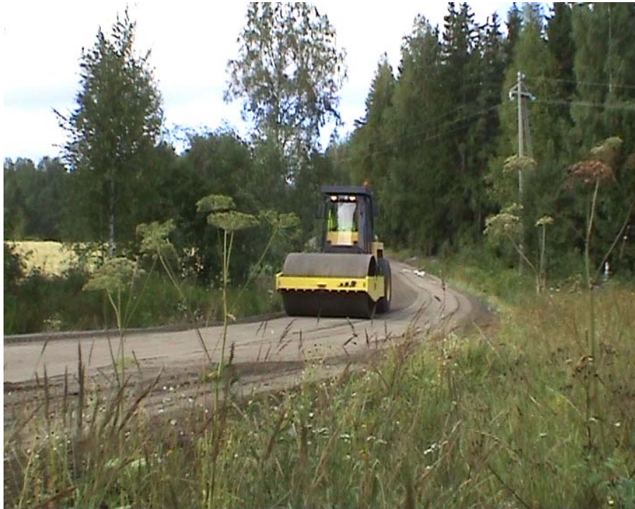
Kuva 18: Kuitutuhkakerrosta tiivistetään jyrällä. Pihtisalmentie, Luopioinen, 2003.
