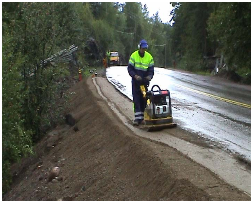
Kuva 14: Uutta rakennekerrosta tiivistetään murskeen päältä. Luopioinen Kt 322, 2003.
