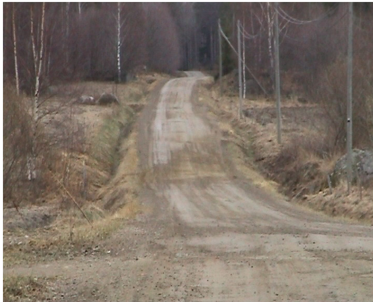
Kuva 8: Pihtisalmenttiä (Pt 13981) keväällä 2003, ennen kunnostusta. (SCC Viatek Oy)
