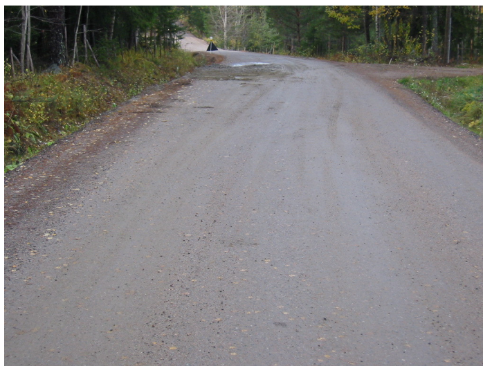
Kuva 9: Pihtisalmentie (Pt 13981) syksyllä 2003, kunnostuksen jälkeen. Kuva on samasta kohdasta mutta päinvastaiselta suunnalta otettuna kuin kuva 8. (SCC Viatek Oy)
