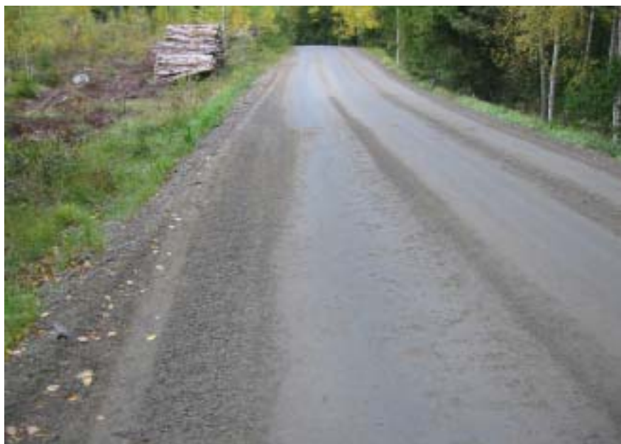
Kuva 6. Pilot 2002. Pintamurskekerroksen paksuuden vaihtelut syksyllä 2003.
