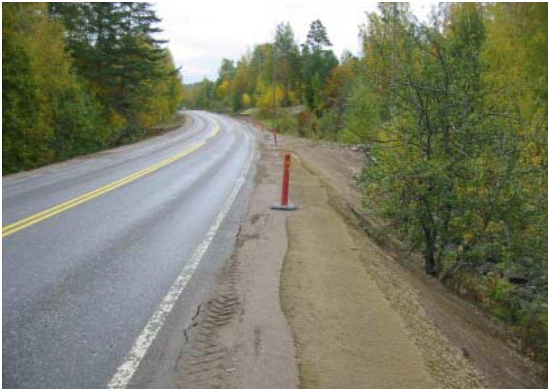
Kuva 17. Pilot 2003. Piennarlevennys ennen päällystämistä.
